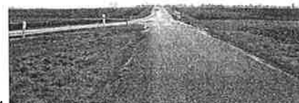
La Route Départementale 1
